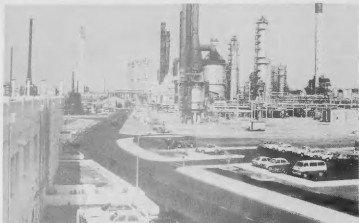
Caminda principal ■ refinaria.
